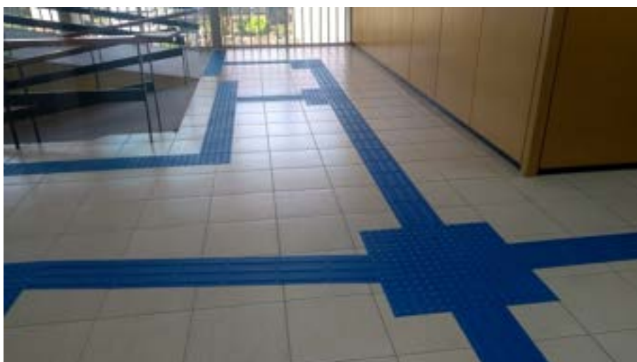
Imagens 09 e 10 - Piso tátil instalado no 7º andar do edifício-sede do STM
