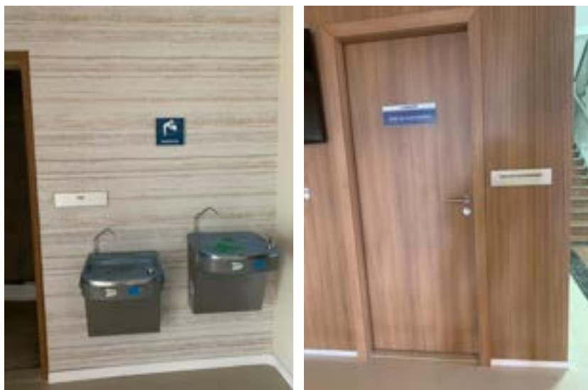
Imagens 16 e 17 - Bebedouro acessível e placas em braile para identificação de ambientes no edifício-sede da ENAJUM
