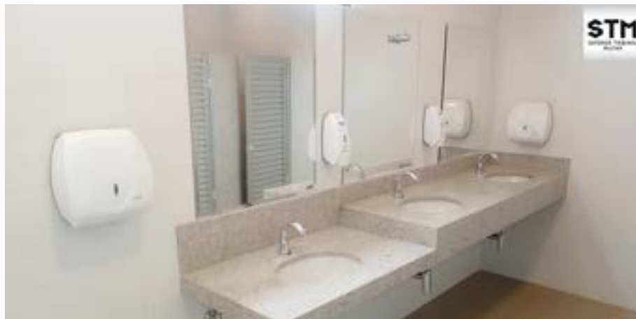
Imagem 24 - Sanitário coletivo com bancada rebaixada no edifício-sede da ENAJUM
