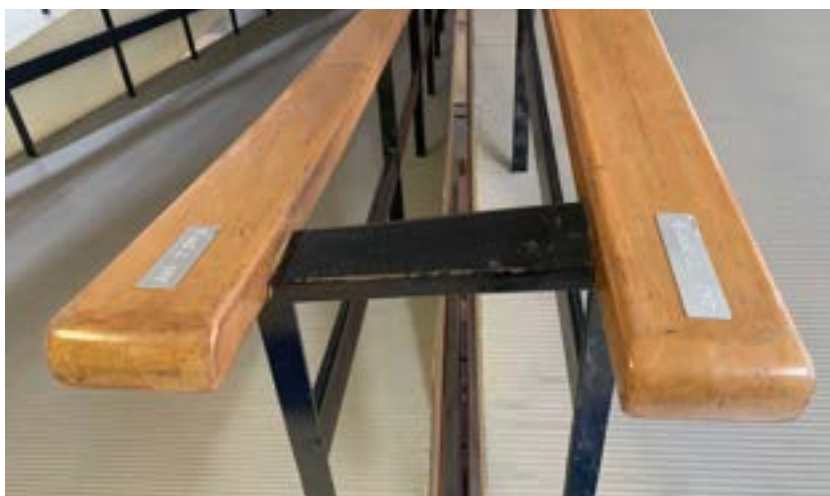
Imagens 12 e 13 - Sinalização tátil para corrimãos instalada do subsolo ao 13º andar do edifício-sede do STM na escada e na rampa central
