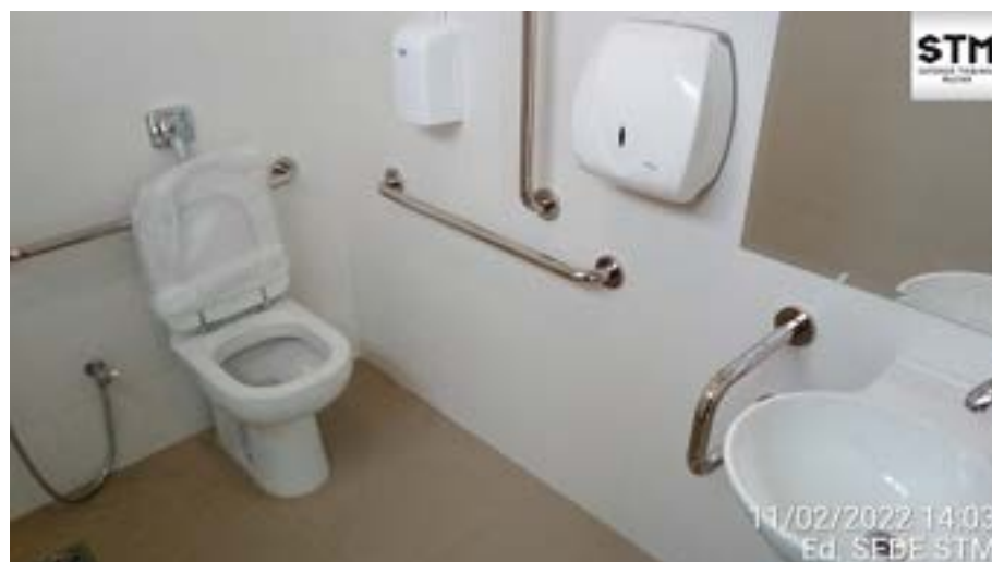
Imagem 22 - Sanitário acessível à PcD no edifício-sede da ENAJUM executado conforme projeto
