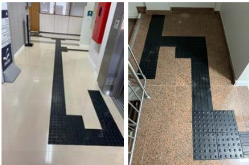
Imagens 14 e 15 - Piso tátil no edifício-sede da ENAJUM
