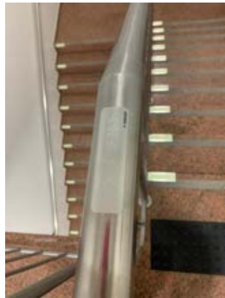
Imagens 19 e 20 - Pictogramas para pessoa com cadeira de rodas (PCR) no auditório e sinalização tátil para corrimãos do edifício-sede da ENAJUM
