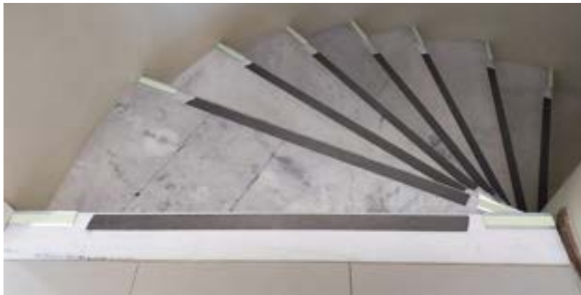
Imagem 11 - Sinalização de degraus instalada na escada desde o subsolo até o 13º andar do edifício-sede do STM
