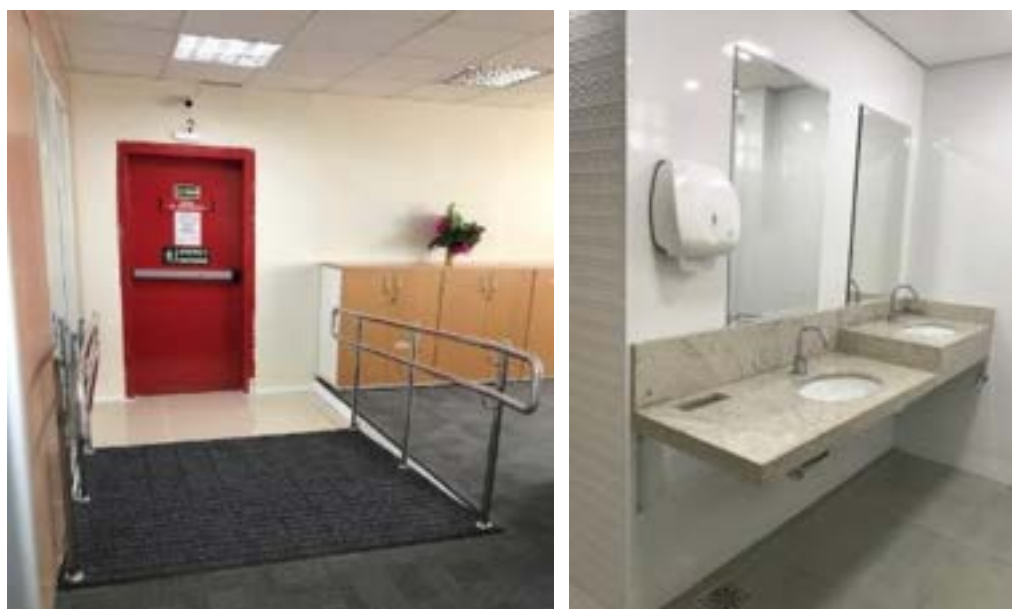
Imagens 04 e 05 - Reforma do 12º andar do STM, com rampas acessível e bancada com trecho rebaixado
