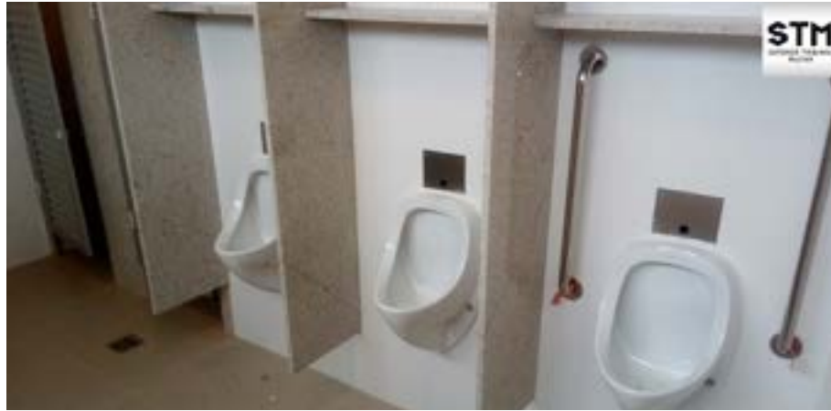
Imagem 23 - Sanitário coletivo com área de mictório acessível no edifício-sede da ENAJUM
